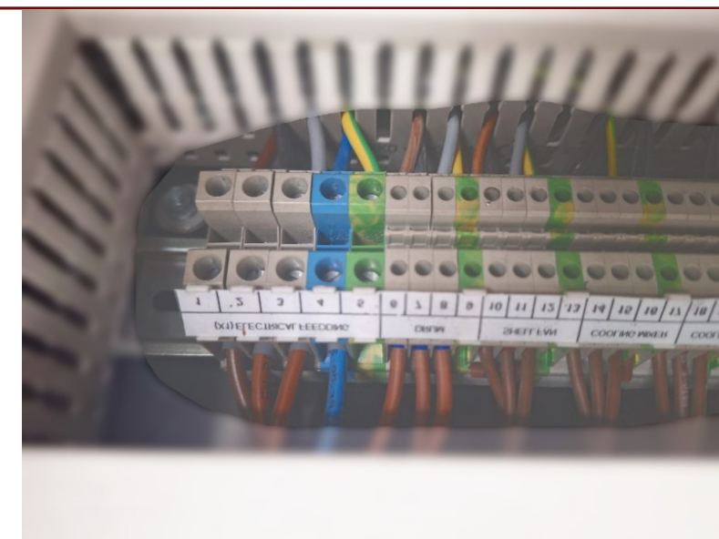
Крайняя левая группа из 5 клемм. Слева направо: L1, L2, L3, N, PE.
